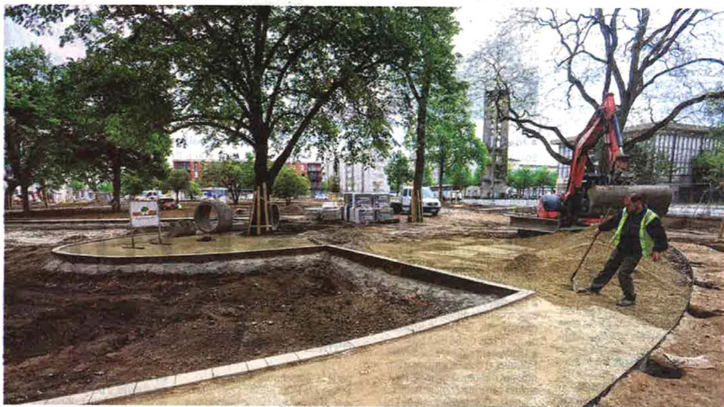
Les travaux d'aménagement de la place de l'Ile de France ont débuté à l'automne 2016 et se poursuivront jusqu'à l'automne prochain. Sur cette place centrale, le square comprendra des espaces verts multi-usages et une grande aire de jeux, pour les enfants de trois à douze ans. PHOTO DNA - CÉDRIC JOUBERT
